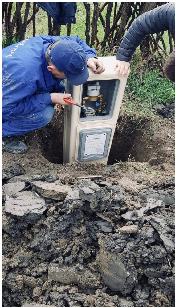
FOTO: MONTARE CAMIN BRANȘAMENT - CONTORIZARE E-CUB, VESTRA INDUSTRY
