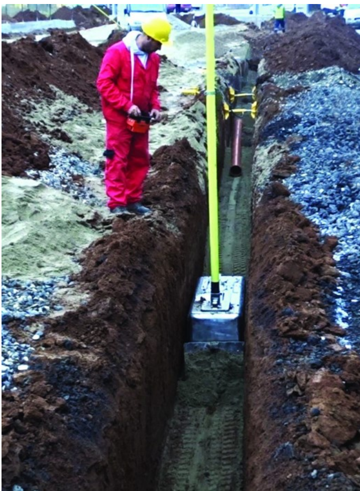
FOTO: TEHNOLOGIA ROBOTERR PENTRU REALIZAREA LUCRĂRILOR DE CONSTRUCȚIE A REȚELOR DE CANALIZARE, SURSA: ROBOTERR SEWERAGE CONSTRUCTION
