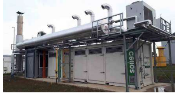
Figura 2. Grup microturbine Tg. Mureș Figure 2. Tg. Mureș microturbine group
