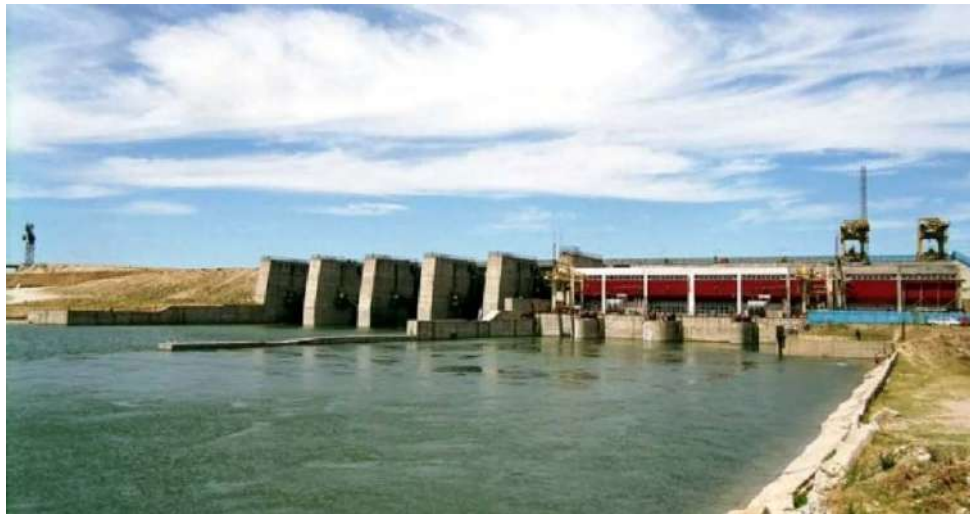
Figura 2. Hidrocentrala Izbiceni Olt (vedere din aval)
